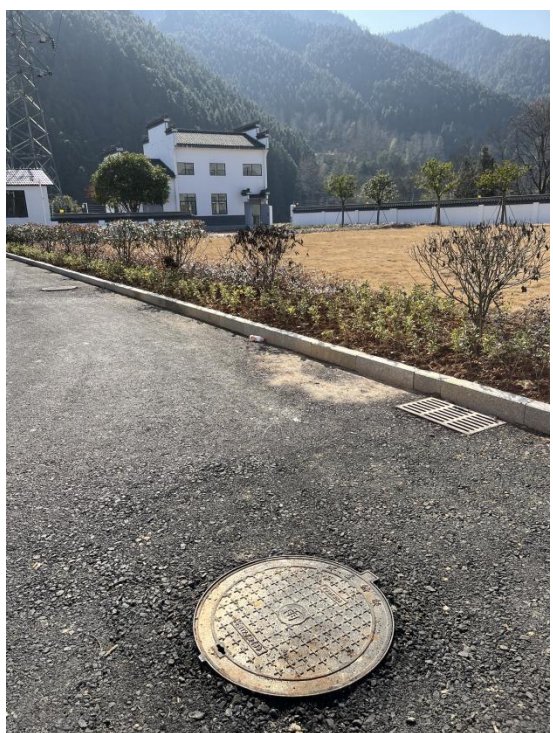
道路旁的雨水管网
